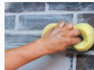
Finalmente, sugerimos ampliamente aplicar un sellador especialmente diseñado para productos de barro para proteger su fachada contra los efectos naturales de su exposición a la intemperie.
