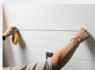
**Ejemplo:** Si el promedio del alto de las piezas resulta en 6.7 cm y consideramos una marca por cada dos hiladas de fachaladrillo más sus dos boquillas, la separación entre líneas será de 15.4 cm.
