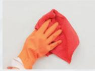
**1.** Limpie la superficie de polvo, pintura, aceites o impurezas que impidan la adherencia del adhesivo.
