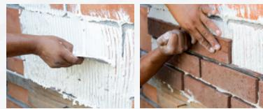
**5.2.** Coloque cemento adhesivo de contacto distribuyendo uniformemente sobre el muro usando una liana de 1/4" x 1/4" y presione el fachaladrillo sobre el adhesivo.
