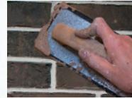
**6.2. Acabado Rústico;** Use una boquilla arenosa premezclada y prepare siguiendo las instrucciones del fabricante de la boquilla. Distribuya la pasta de boquilla sobre la superficie del fachaladrillo con una liana, esparciendo la mezcla uniformemente. Retire los excesos con una esponja limpia y húmeda. Enjuague frecuentemente la esponja para facilitar la limpieza.
