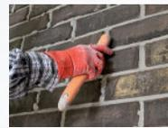
**6.1. Acabado Clásico;** Use una boquilla arenosa premezclada y prepare siguiendo las instrucciones del fabricante de la boquilla. Aplique en la junta usando una duya. Posteriormente, limpie los excesos con un cepillo plástico de cerdas suaves o esponja limpia. Finalmente, sugerimos ampliamente aplicar un sellador especialmente diseñado para productos de barro para proteger su fachada contra los efectos naturales de su exposición a la intemperie.
